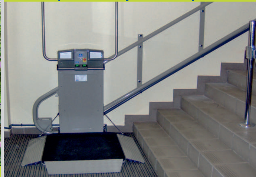
platforma z najazdem bocznym
